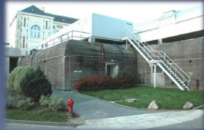
Bunker hôpital de Cherbourg (Manche)
