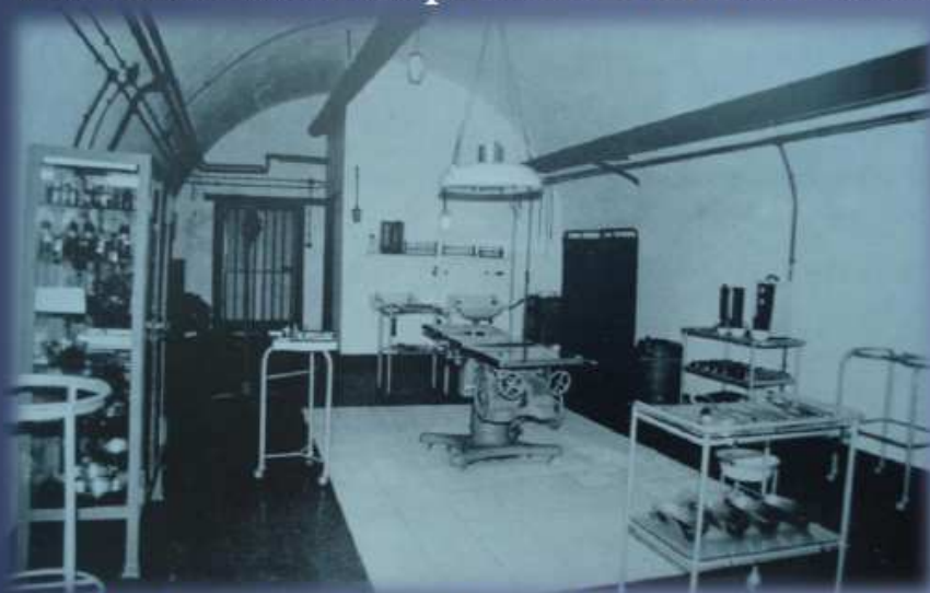
Salle d'opération. Hôpital souterrain de Jersey
